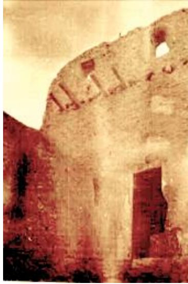
بعض تفاصيل البناء العلوي للحصن الطيني (قلعة القزة) مع الممر الواصل بين الكوات عبر السور
